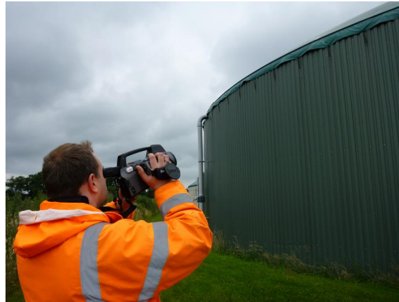
Überprüfung der Folienabdichtung am Fermenter.
